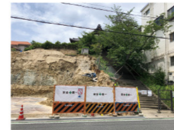
工事現場(千里山)
